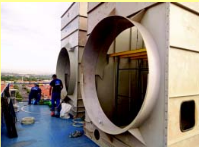
Montagem dos resfriadores entre as etapas da reta final da obra
