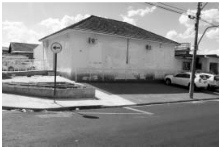
Central de Monitoramento próxima da fase final da obra
